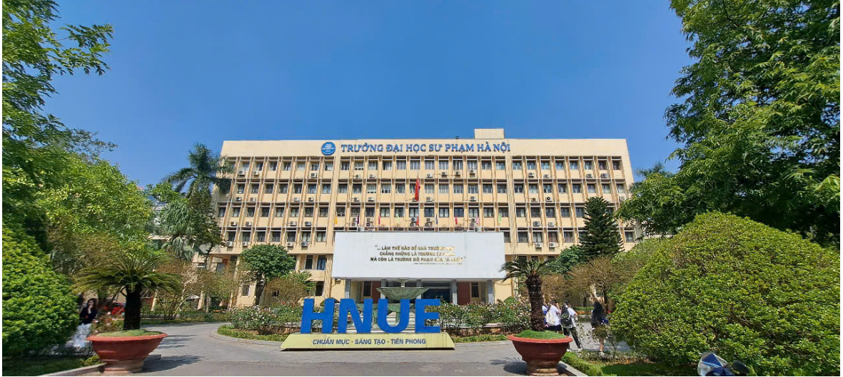
Ảnh 1. Toàn cảnh trước nhà Hiệu bộ trường ĐHSPhN (NCS chụp, tháng 8/2024)
